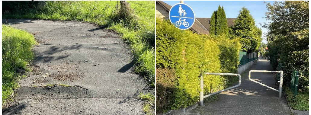
Ausbau & Sanierung (Wiesenweg) Einbauten entfernen (Kettelerstr.)
