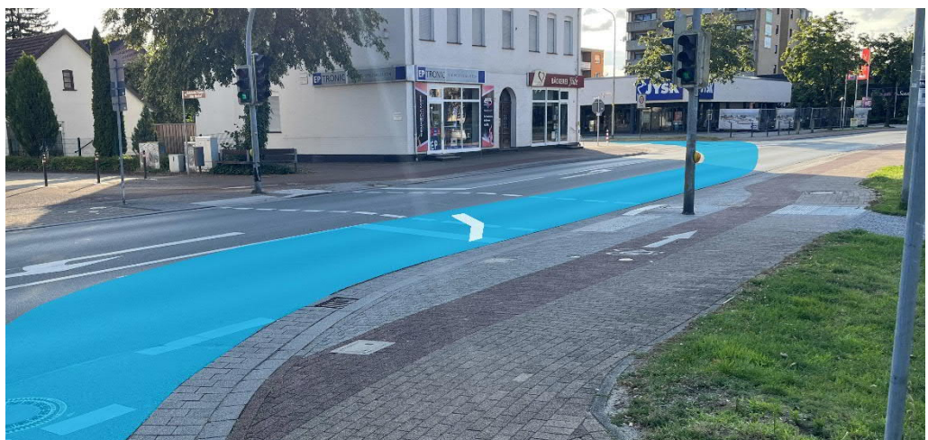
Abb. 46 Weg bei der Querung Bahnhofstr. – Kirchstraße im Mischverkehr
