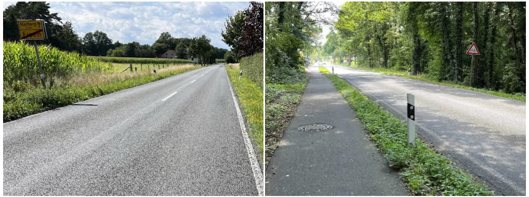
Radwegneubau prüfen (Espelner Str.) Ausbau erforderlich (Detmolder Str.)
